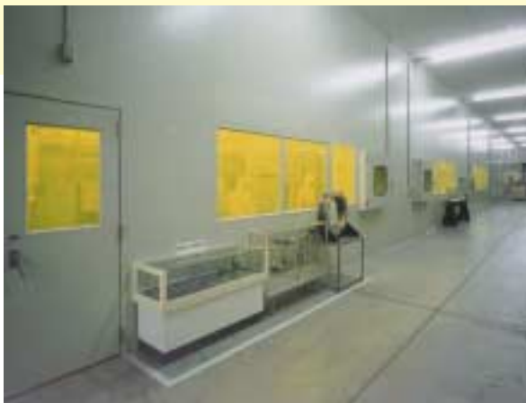
クリーンルーム 最終洗浄工程では クラス1000の管理を実施しており、 特殊仕様ではクラス100の 管理も可能です。 Clean room
